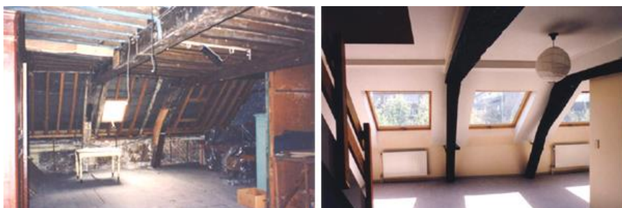
Projet Quai au Foin - une pièce sous toit, avant et après rénovation !
